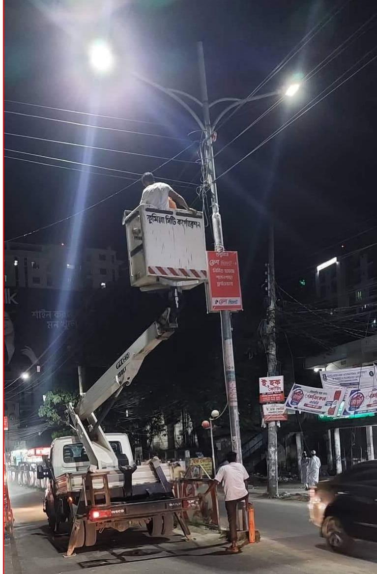
বিম লিফটারের মাধ্যমে সড়ক বাতি স্থাপন ও মেরামত কাজ
