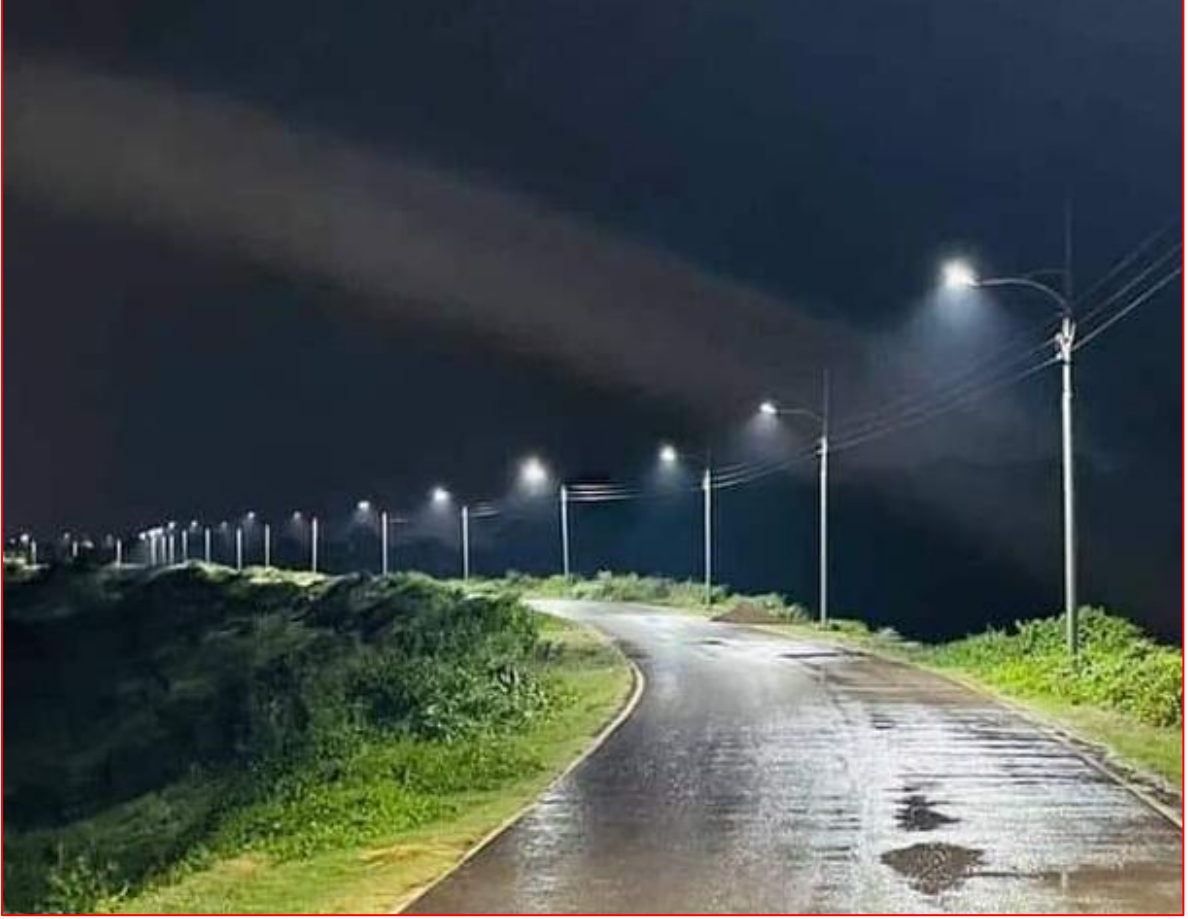
গোমতী বাইপাস সড়কে স্ট্রিট লাইট স্থাপন
