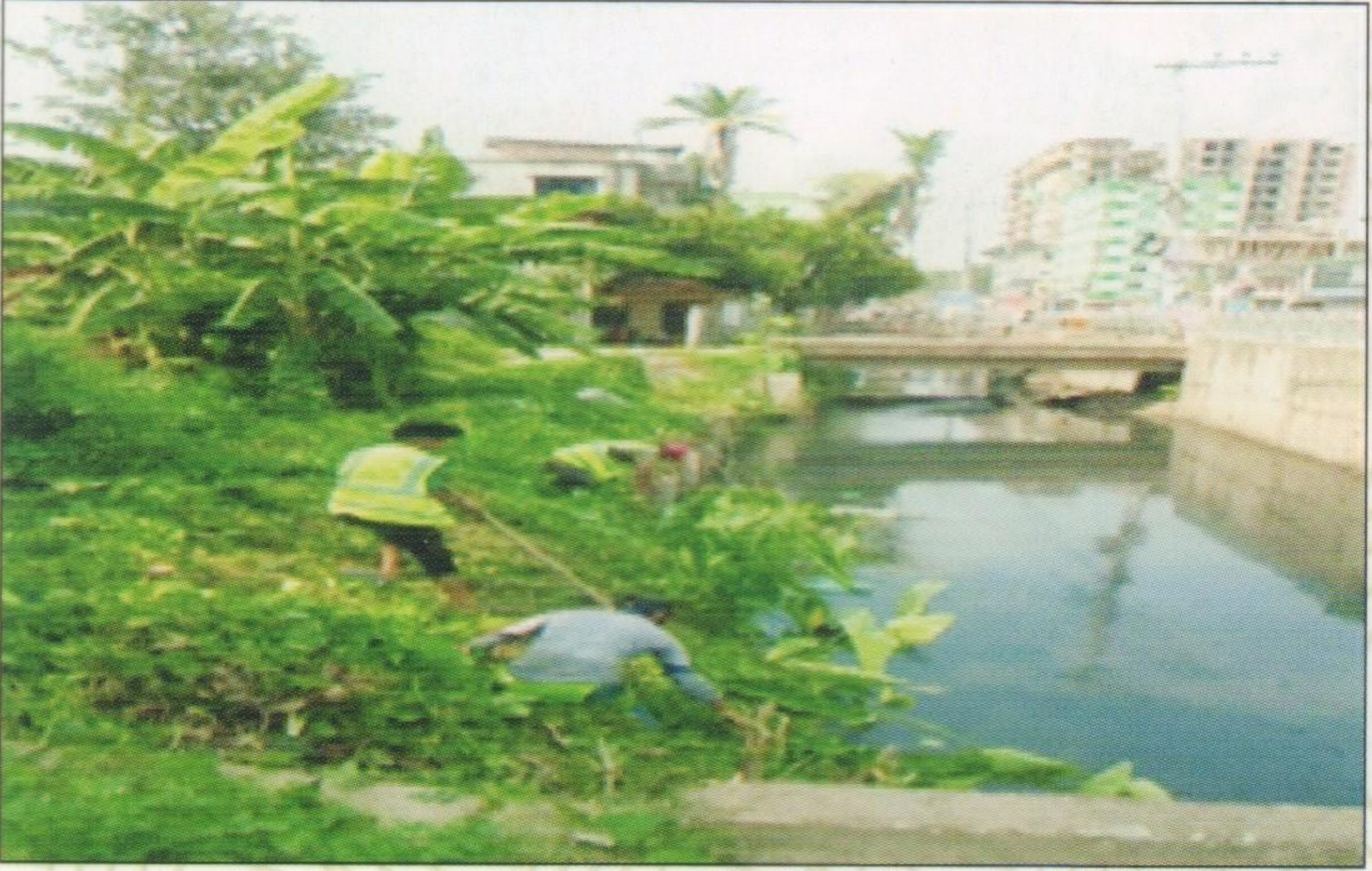
খাল পরিস্কার কার্যক্রম
