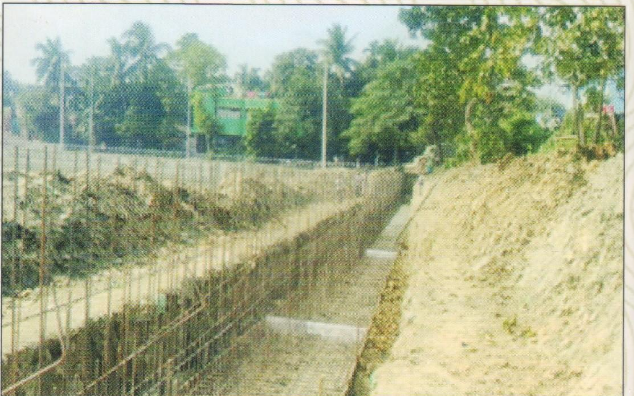
গাইড ওয়াল নির্মাণ কার্যক্রম
